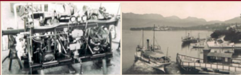
Die GISELA verfügt über eine der letzten im Dienst stehenden oszillierenden (bewegliche Zylinder) Verbund-Dampfmaschinen, Baujahr 1870
