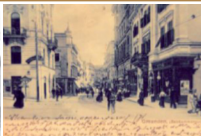
Ein Blick in die Theatergasse Richtung Rathausplatz und Kammerhofgasse um 1900
