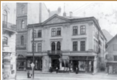
Das am 22. Juni 1872 eröffnete Gmundner Theatergebäude
