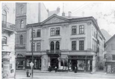
Das am 22. Juni 1872 eröffnete Gmundner Theatergebäude
